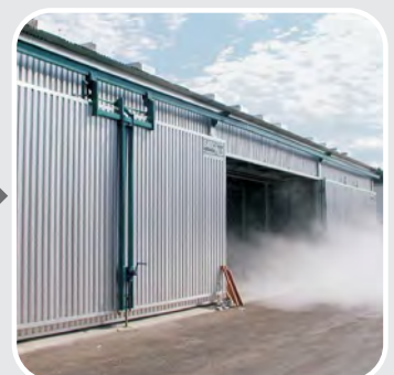
Intalatii complete de uscare a lemnului.
